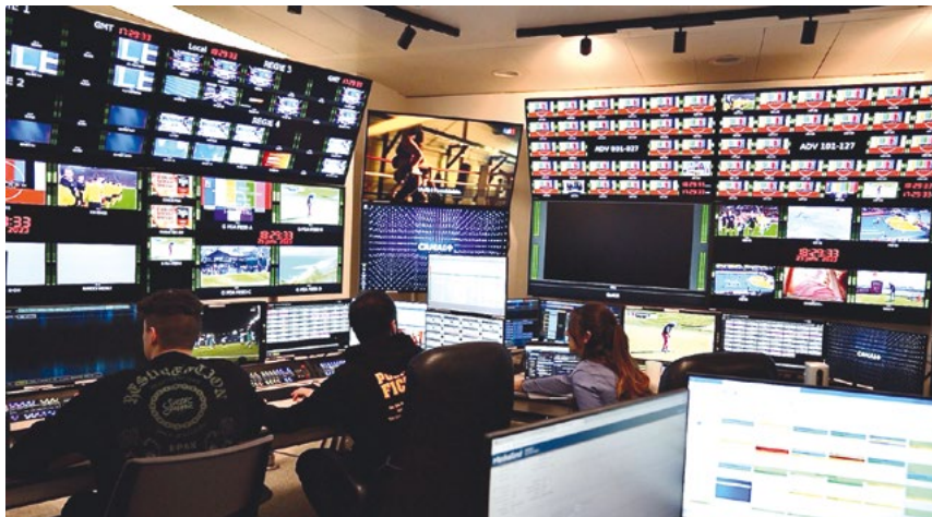
Vue partielle du nodal installé à Canal One, basé sur les infrastructures ST-2110. © Mediakwest
